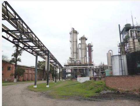
La destilería tiene problemas serios de contaminación del medio ambiente, ya que no tienen implementado sistemas de tratamientos adecuados a las vinazas que se generan en la destilación.
